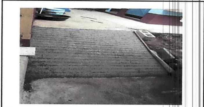
Foto 2: Reconstrucción de torta de concreto 10 cms de espesor en patio del establecimiento.
