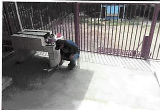
Foto 8 Mejoramiento de torta de concreto (nivelación y alizado)
